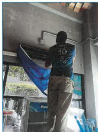
ภาพถ่ายที่ 2.2-21 การทำความสะอาดระบบปรับอากาศ
