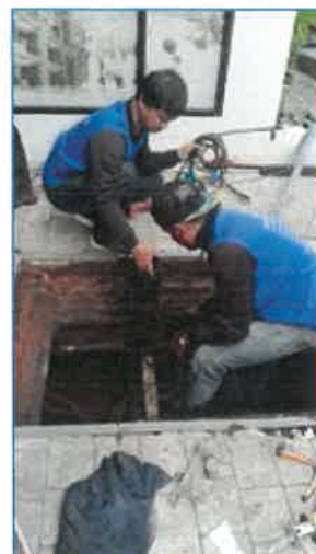
การแก้ไขระบบบำบัดน้ำเสียขนาด 80 ลูกบาศก์เมตร
