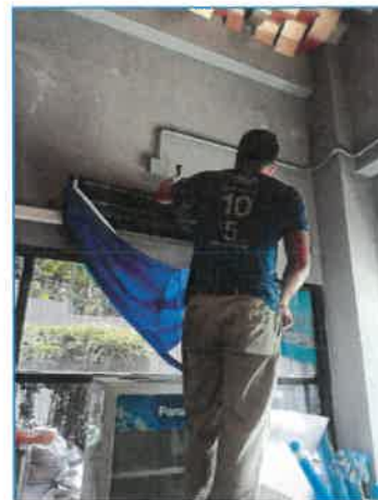
ภาพถ่ายที่ 2.2-21 การทำความสะอาดระบบปรับอากาศ
