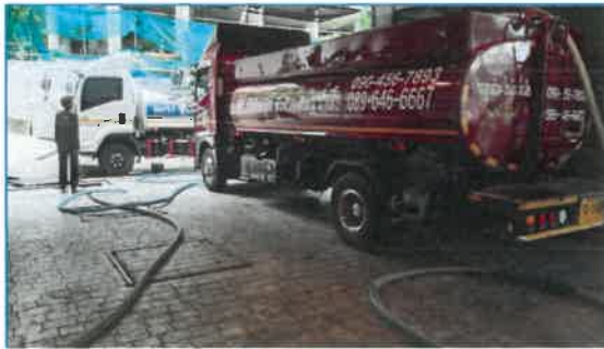
ภาพถ่ายที่ 2.2-14 การสูบน้ำจากตะกอนส่งกำจัด
